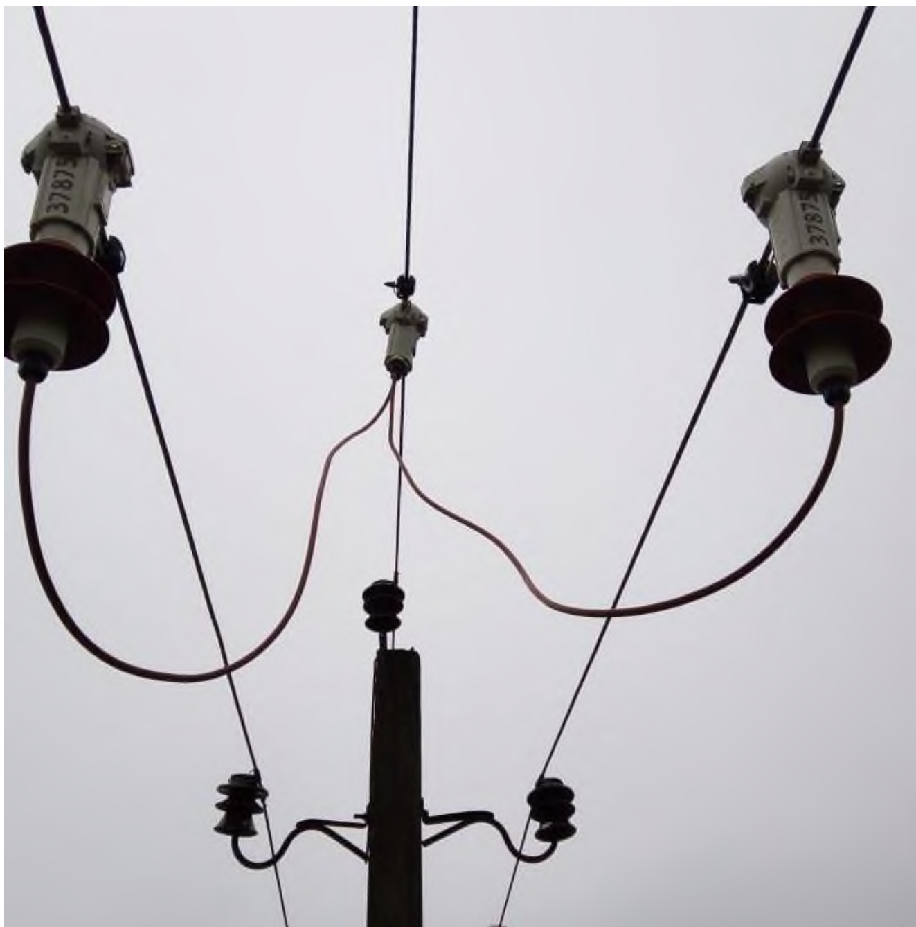
Рис. 16 – Правильное расположение кабелей ВПУ на линии ВЛ.
